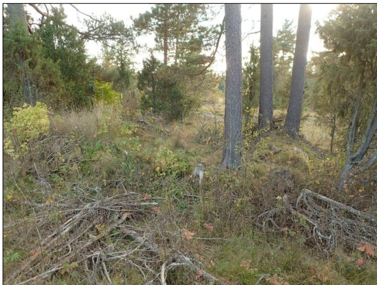
Rakennuksen perustan pohjoispäätä, länteen.
